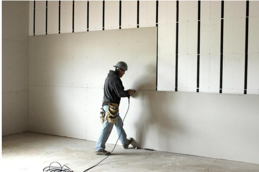
Figura 17 – Fixação e acabamento Paredes Internas
